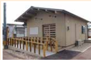
みんなの家(西原村小森第4仮設団地)
