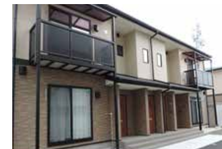
災害公営住宅・美里町御蔵場住宅 (2階建てアパート形式) (宮城県美里町)
