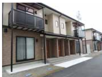
2階建てアパート形式の災害公営住宅・ 御蔵場住宅(24戸)
