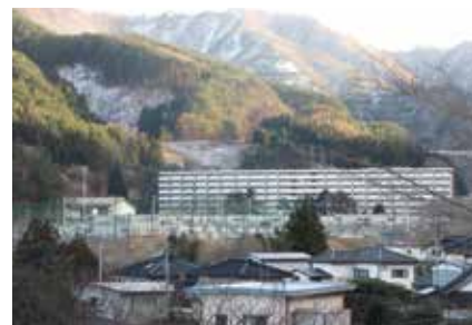
県営釜石市平田団地 (岩手県釜石市)
