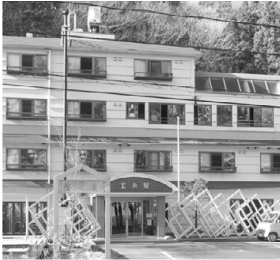
▲活動拠点となっている旅館「宝来館」(釜石市鶴住居町)
