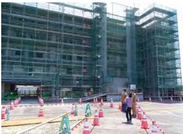
建設中の閑上中央第二団地の外観
