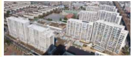
建て替え後の草加松原団地
