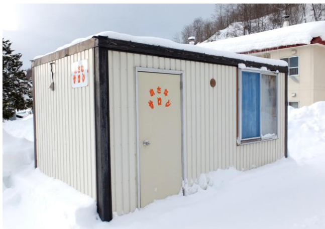
小さなサロン(外観)
