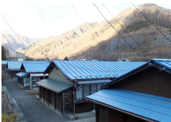
アーティストが滞在することもある 足尾銅山長屋（南橋地区）
