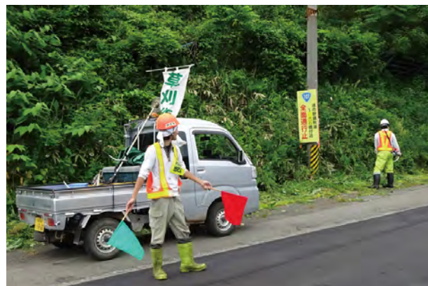
国道の除草作業中
