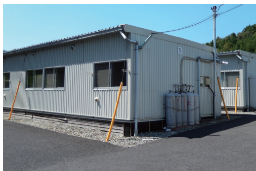
桜沢地区応急仮設住宅
