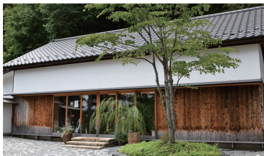
地域になじむ伝統的な外観で住民を気持ちよく迎え入れる
