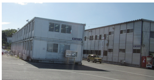
山元町役場仮庁舎
