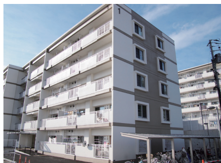
鹿野復興公営住宅の外観
