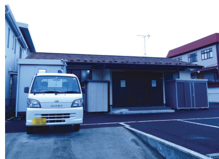
八幡下二集会所。津波で全壊も、13年に新築され、以降地域の活動拠点に
