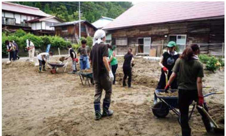
ボランティアによる泥の撤去作業(写真提供:金山町社会福祉協議会)
